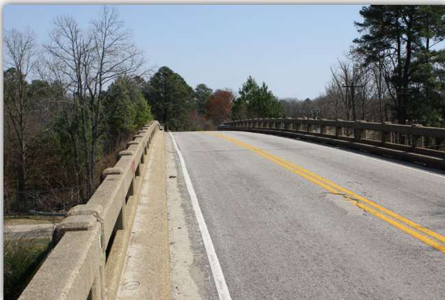
La estructura se extiende sobre G Road y el ferrocarril.
